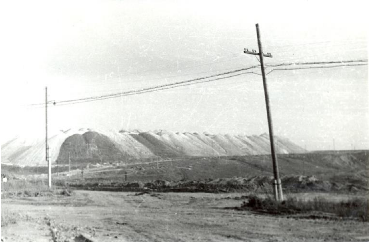
Рисунок 4 – Общий вид конвейерного отвала, сложенного из мело-мергеля и четвертичного суглинка (1970 г.)
