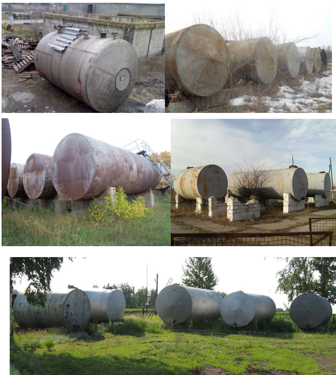
Рисунок 1.3 – Фрагменты неудовлетворительного технического состояния нефтескладов сельхозпредприятий
