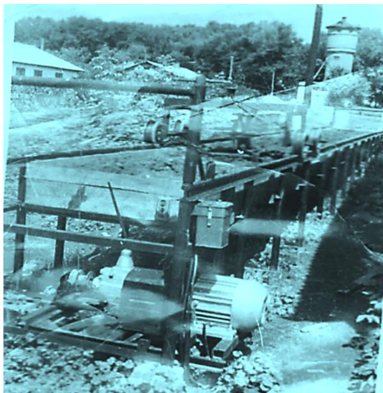
Рисунок 3. 8 — Электростенд с переменной скоростью (4-11 км/ч) движения тележки
